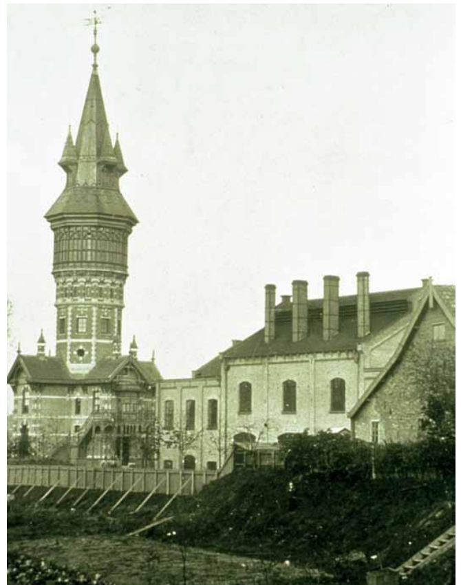
↑ Watertoren net na het gereedkomen van de bouw
