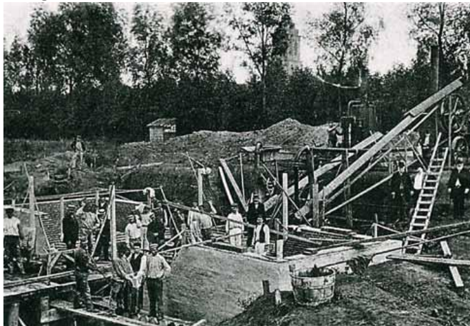
↑ Het fundament van de watertoren
