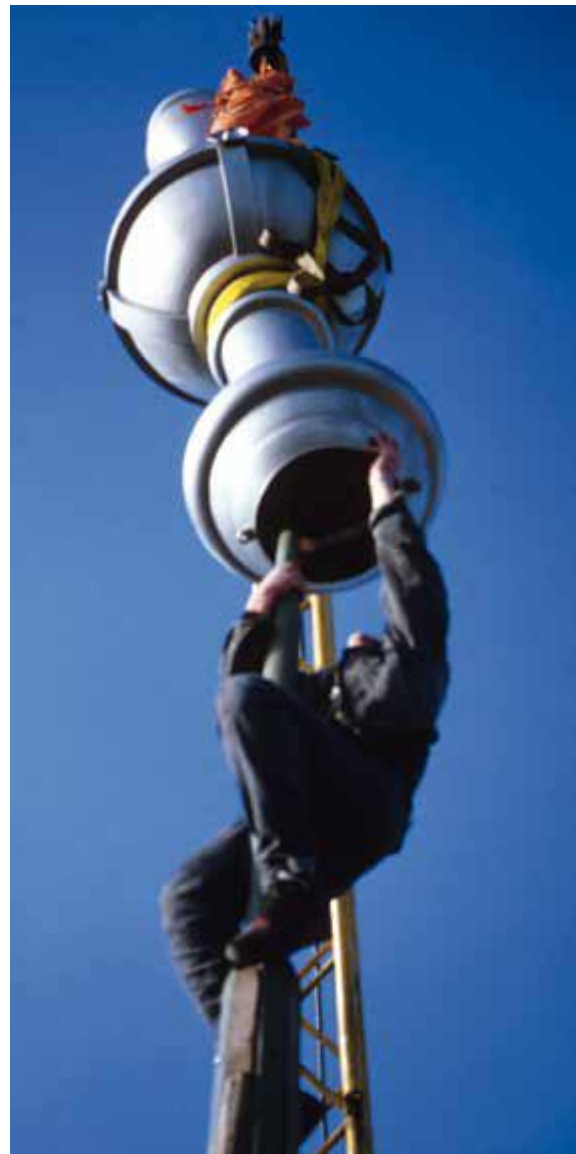
↑ De spits van de watertoren wordt geplaatst
